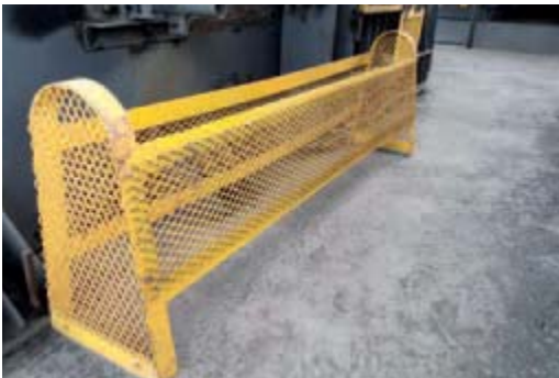
機械防護罩整改
