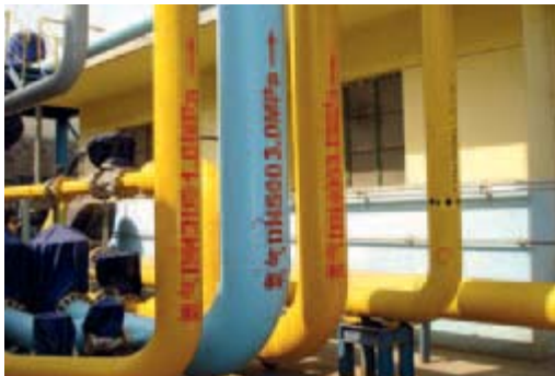
開展防腐工程
