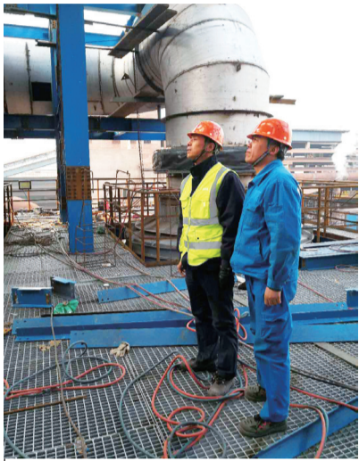
南钢工厂现场
