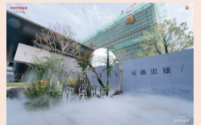
苏州·鹿溪雅园“安藤忠雄ANDO BOX展览”现场
