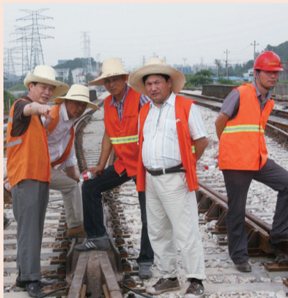
许明来把办公桌搬到工地，现场办公
