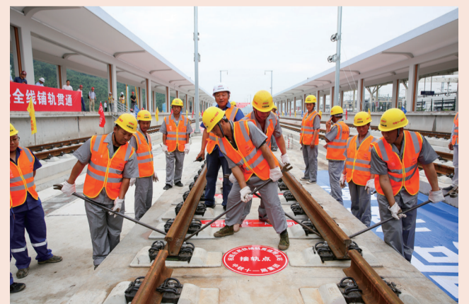
杭绍台最后一段铁轨合龙
