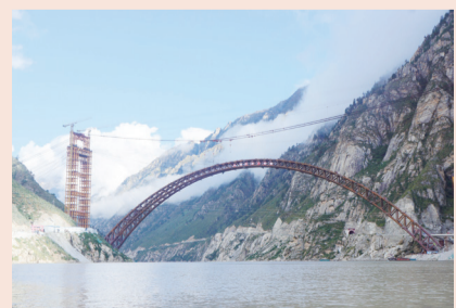
拉林铁路藏木大桥
