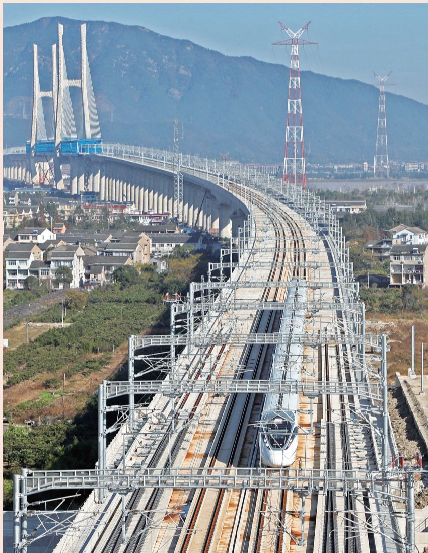
《人民日报》图片新闻：首趟运行试验列车经过杭台高铁椒江特大桥 潘侃俊摄（摄像中国）
