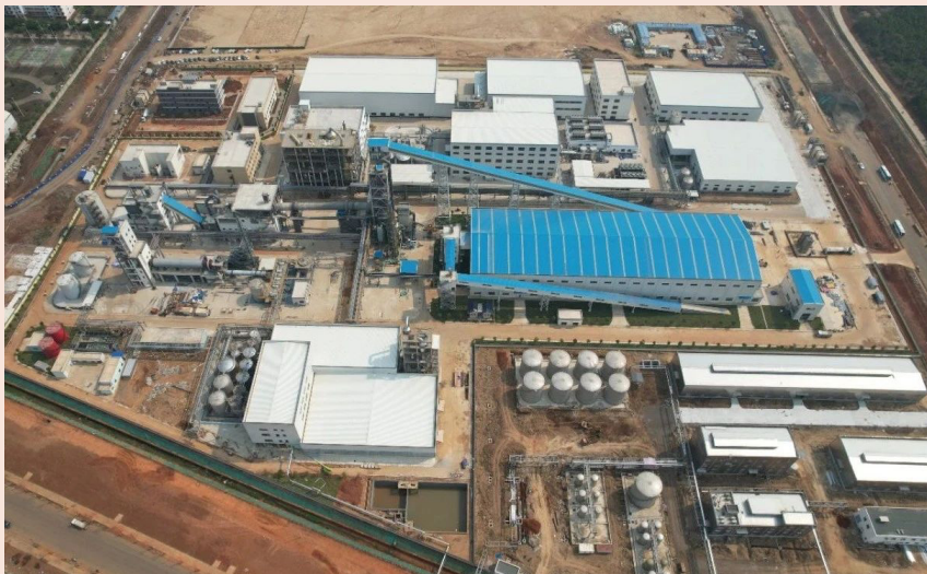
海南洋浦2万吨氢氧化锂项目已完成主体工程建设
